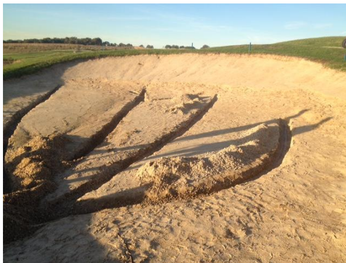
Foto 19. Líneas de drenaje descubiertas.
