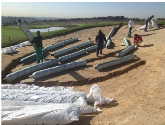
Foto 20. Instalación de drenotube.
