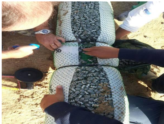
Foto 21. Detalle trabajos instalación.
