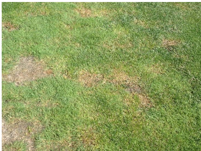
Foto 12. Zona del hoyo 1 en la que se observa la presencia de Agrostis stolonifera .
