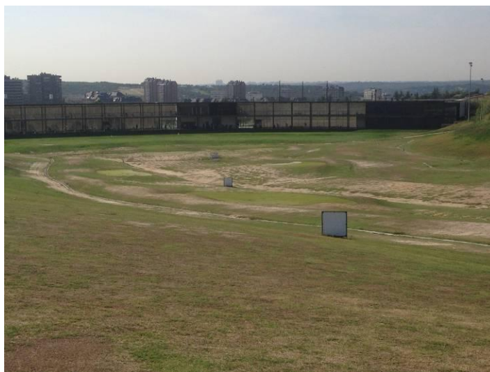
Foto 19. Estado actual de la cancha de prácticas.
