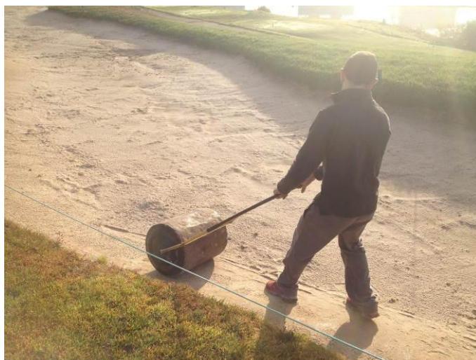
Foto 5: compactación del terreno
