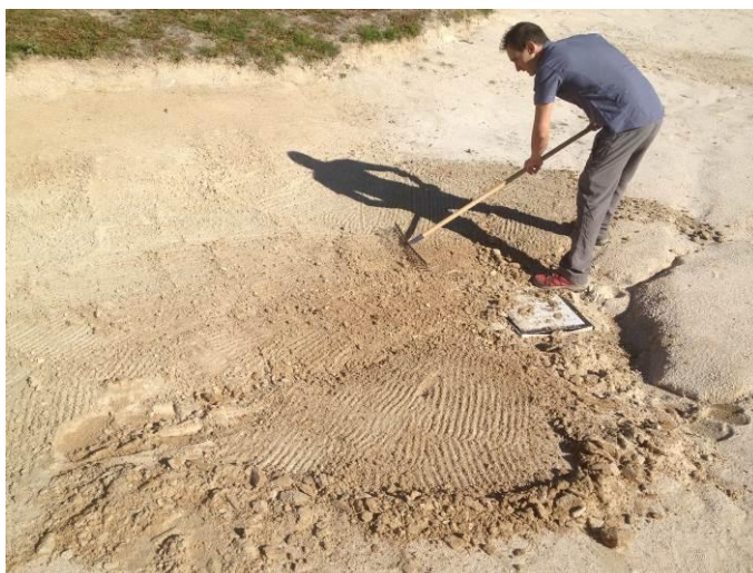
Foto 1: nivelación del búnker
