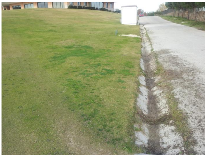
Foto 4: Desbroce de caminos y limpieza de cuneta.
