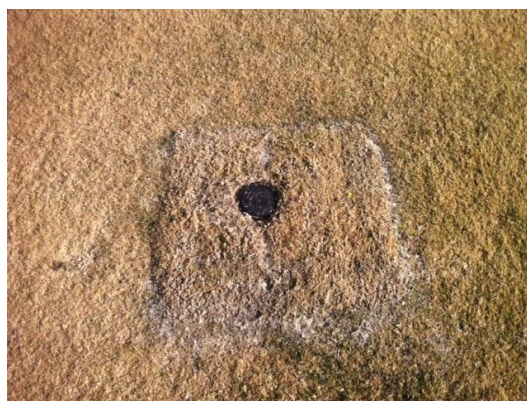
Foto 4 : Nivelación de aspersores
