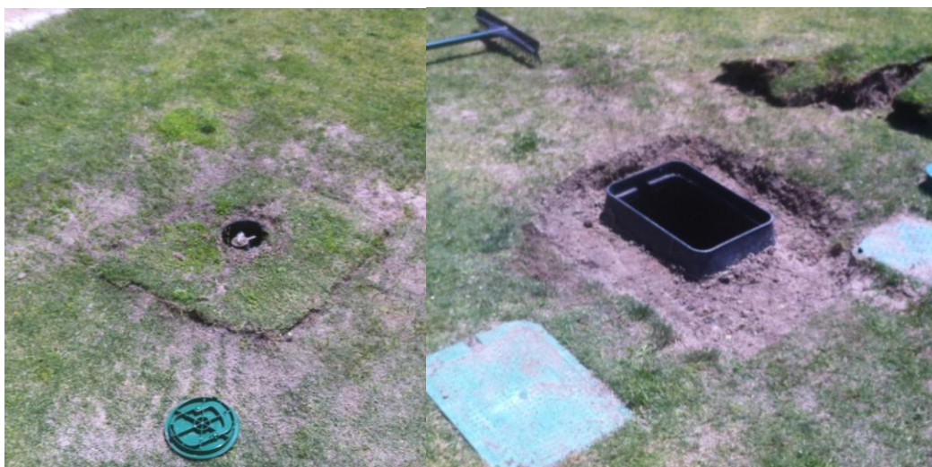
Foto 3: Nivelación arquetas e hidrantes
