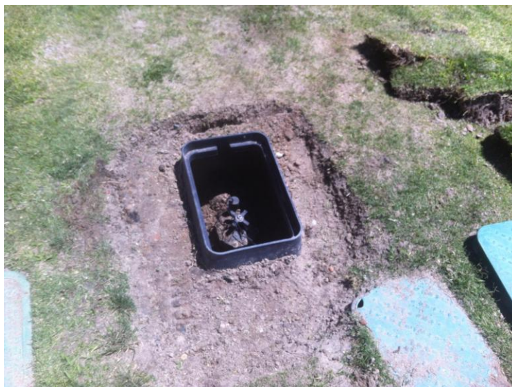
Foto 4: reparación electroválvula
