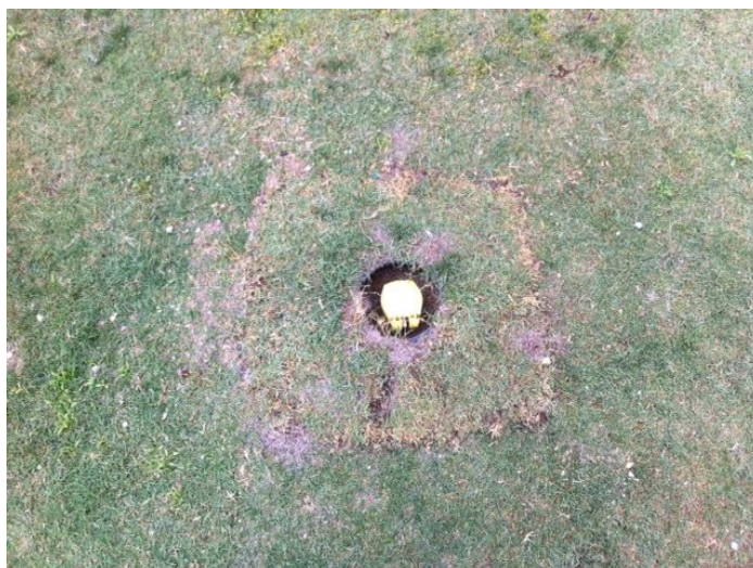
Foto 5: Colocación de un hidrante nuevo.
