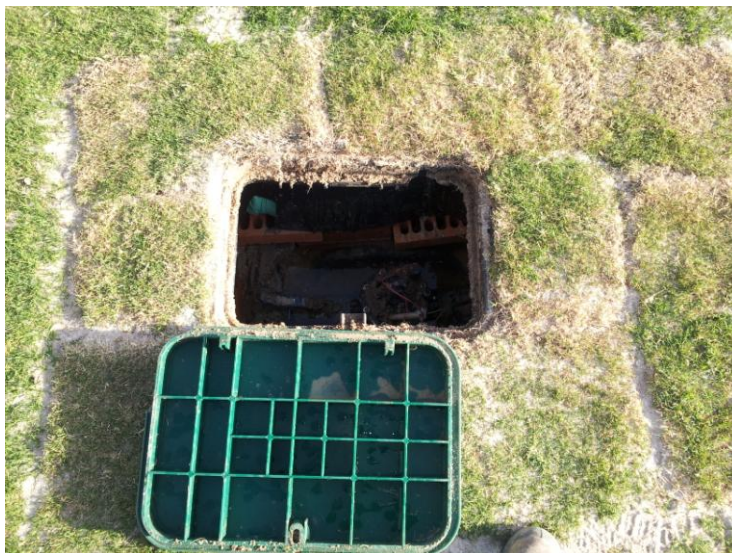
Foto 3: Electroválvula nueva con arqueta nivelada.
