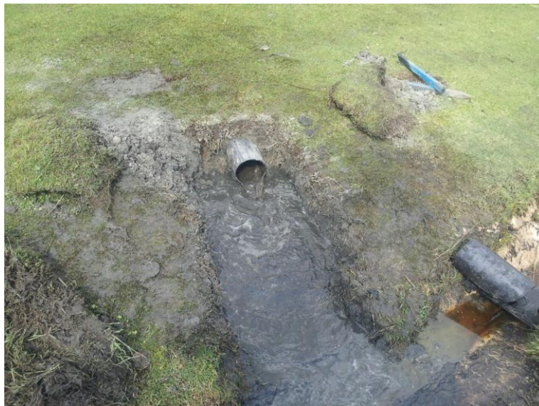
Foto 3. Corte de tubería y limpieza capa negra.
