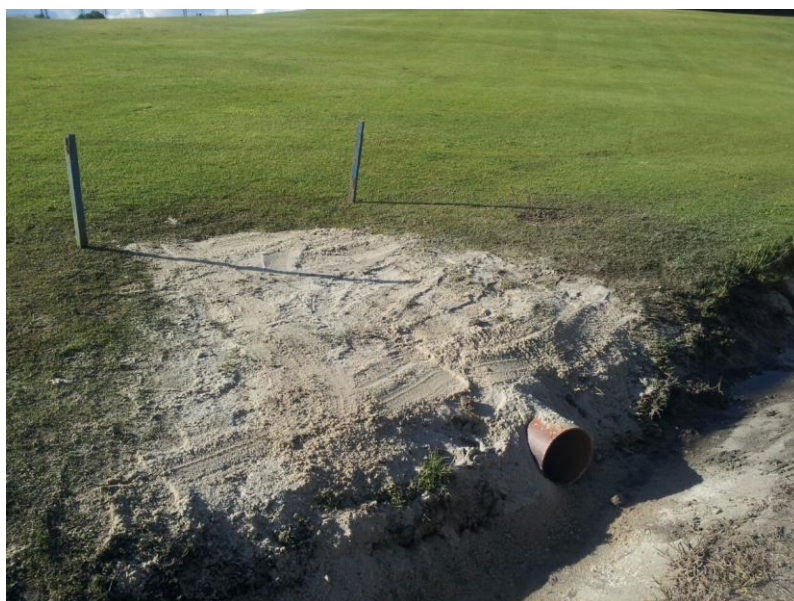
Foto 4. Tubería de drenaje nueva.
