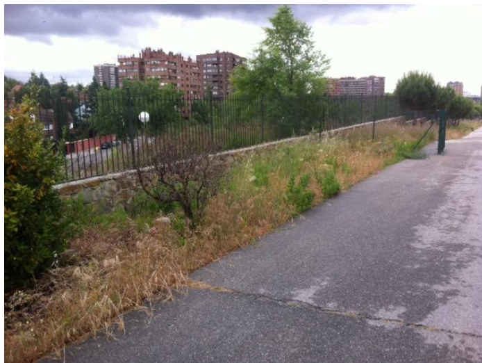
Foto 4: Zona muy descuidada en frente a parking subterráneo.
