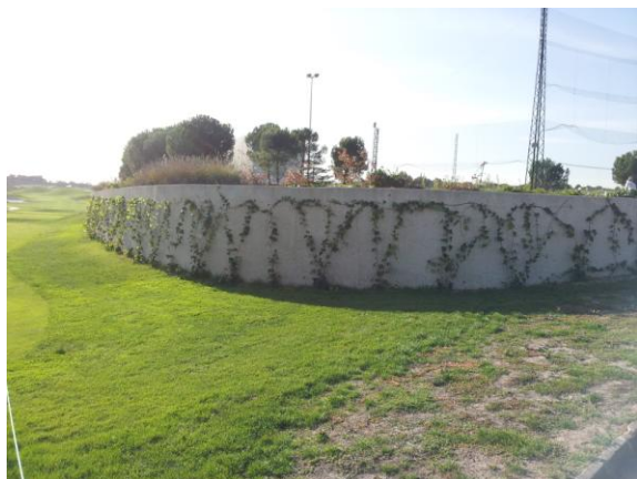
Foto 6: Hiedra en el muro.
