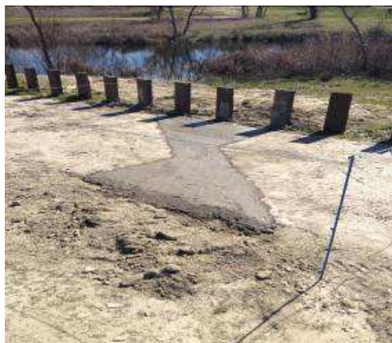
Reparación de camino de calle 17
