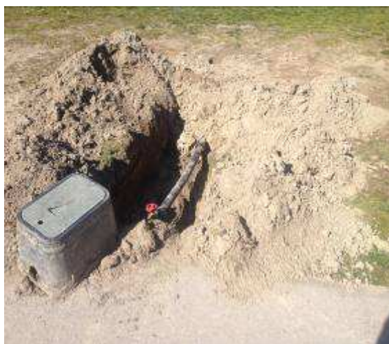
sustitución de llaves
