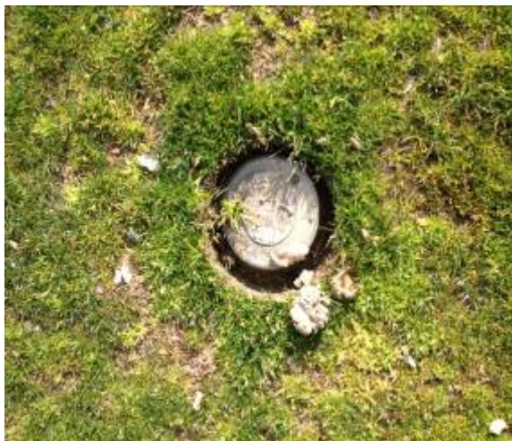
Limpieza de aspersores
