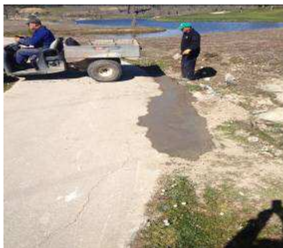
Reparación camino calle 13
