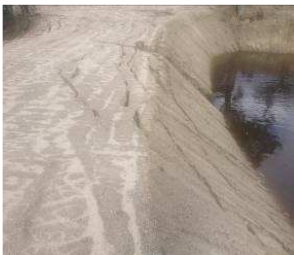
Grieta en el muro de contención de agua
