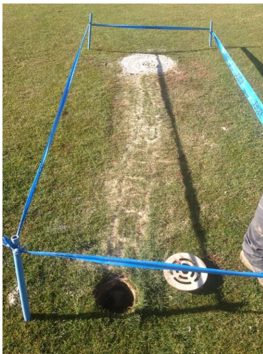
Foto 4. Zona de encharcamiento y modificación realizada.
