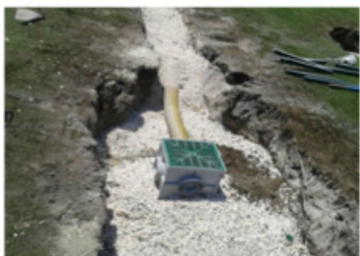
Colocación de grava fina
