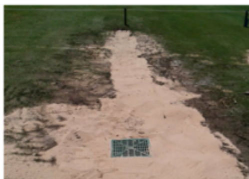
Extendido de arena silicea y nivelación de arqueta
