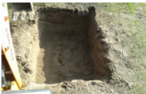
Realización de pozo para recogida de agua
