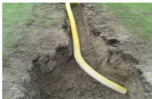
Colocación de tubería para canalizar el agua al pozo
