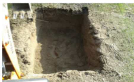
Realización de pozo para recogida de agua
