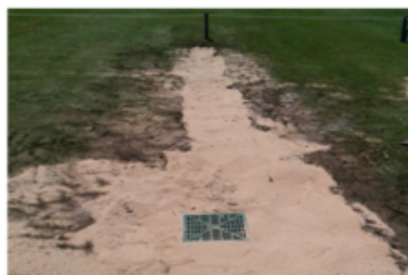
Extendido de arena sílicea y nivelación de arqueta
