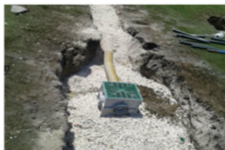
Colocación de grava fina
