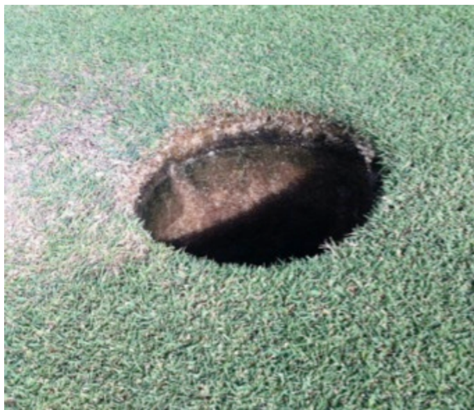
Foto 1: Pérdida de estructura del suelo por la acumulación de materia orgánica, formación de capa negra, contaminación por algas e incorporación de arena de recebo de granulometría fina.
