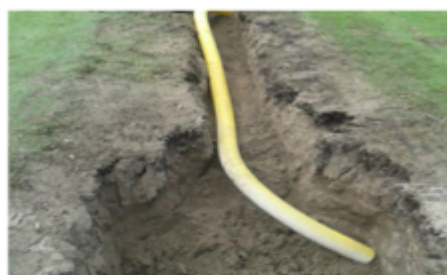
Colocación de tubería para canalizar el agua al pozo
