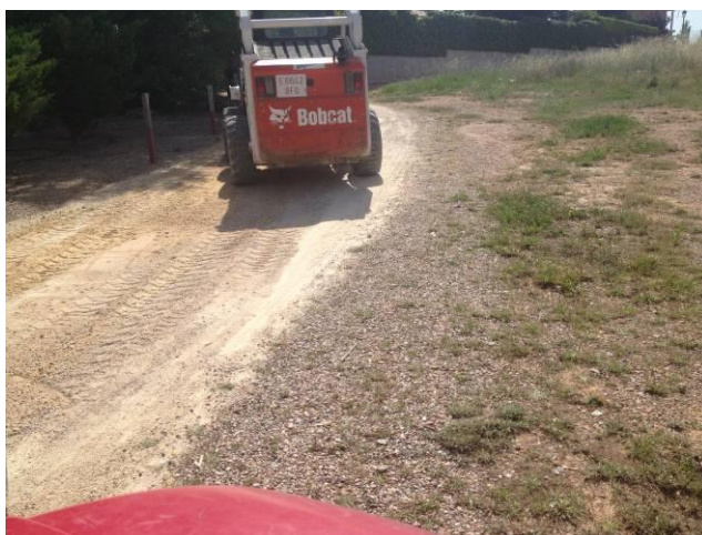
Foto 10. Trabajos de reconstrucción de caminos.
