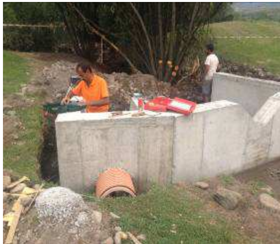
Trabajos de construcción y captación de agua
