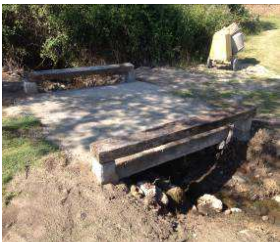
Puente de la calle 5
