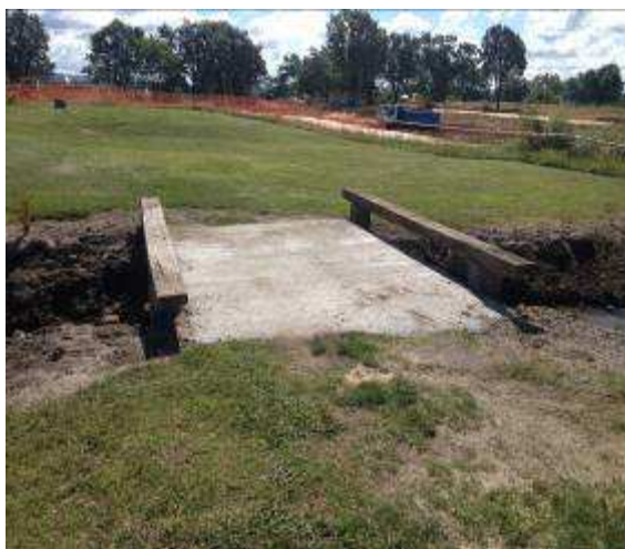
Puente de la calle 6
