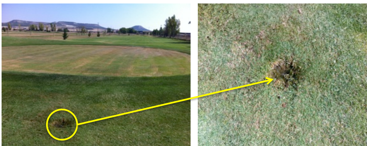
Fotos 6 y 7: Detalle de un aspersor de green completamente enterrado.
