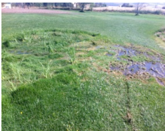
Fotos 15 y 16: Averías detectadas en la red de riego.
