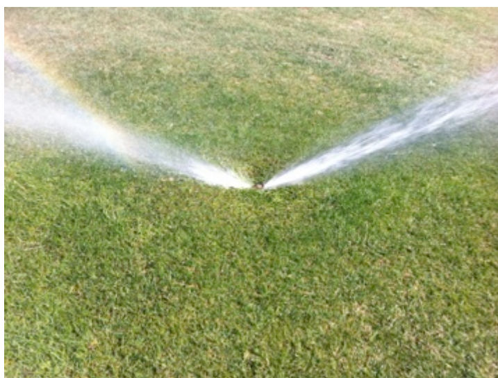
Foto 11: Detalle de un aspersor de tee golpeando el suelo durante el riego.
