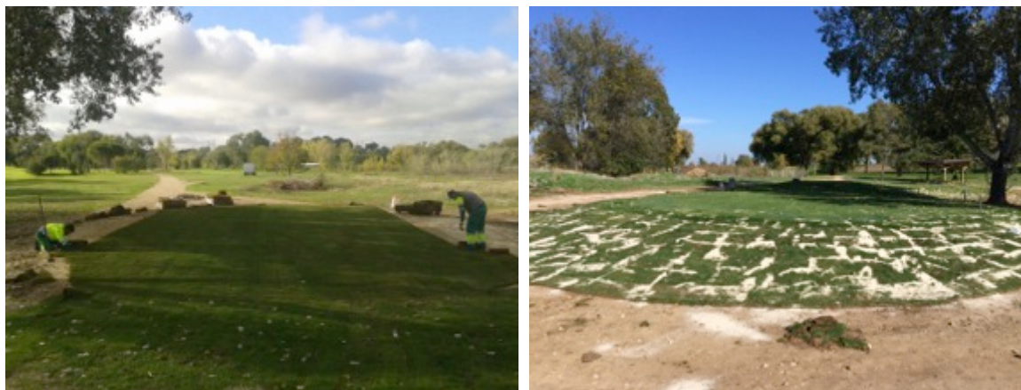
Foto 2: Detalle de la evolución en la construcción del Tee del hoyo 9.
