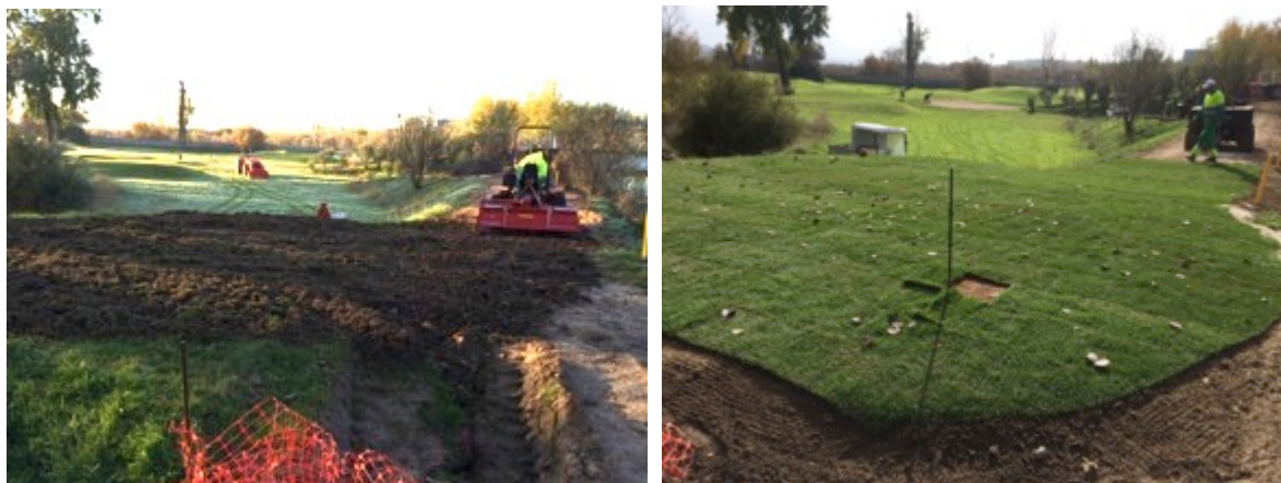
Foto 3: Detalle de la evolución en la construcción de la plataforma de señoras del hoyo 3.
