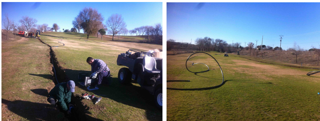
Foto 5: Detalle de la evolución de la renovación del sistema de riego en la calle 11.
