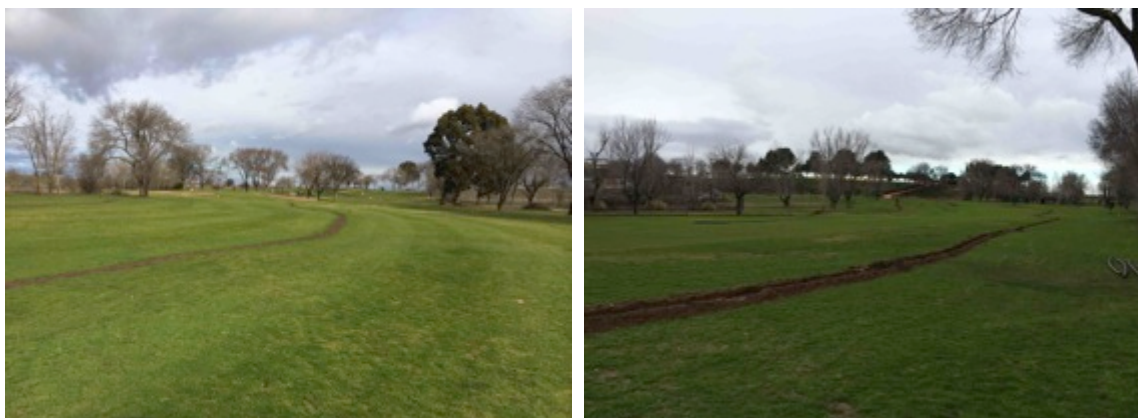
Foto 7: Detalle de la evolución de la renovación del sistema de riego. En la foto, calle 11 terminada (Izq) y calle 1 en ejecución (Dcha).
