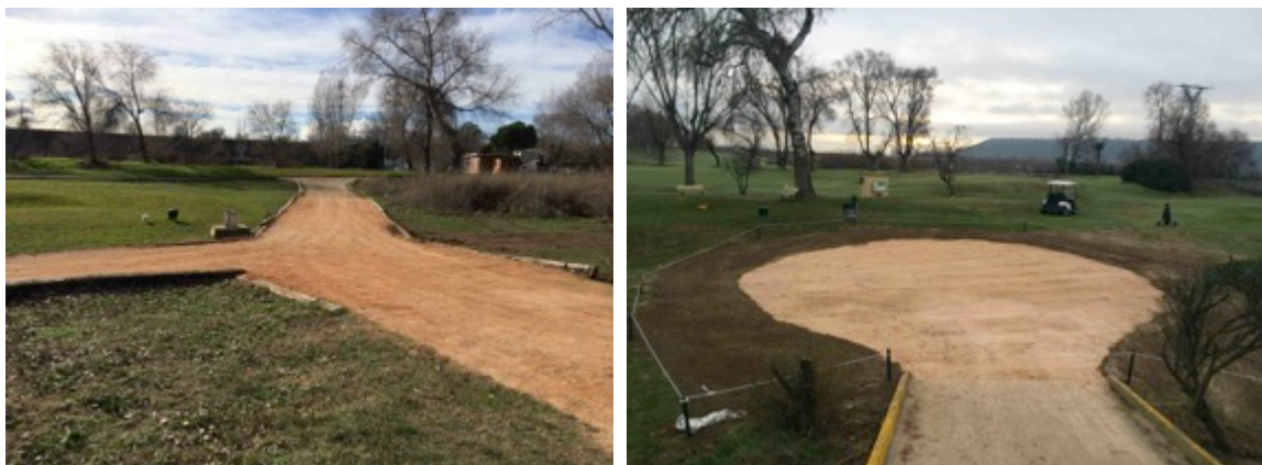
Foto 5: Detalle de la renovación de caminos. Camino del hoyo 1 al 2 (Izq) y construcción de una rotonda en el Tee 3.
