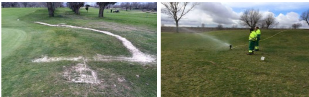
Foto 9: Detalle del replanteo de aspersores por parte de equipo de mantenimiento.
