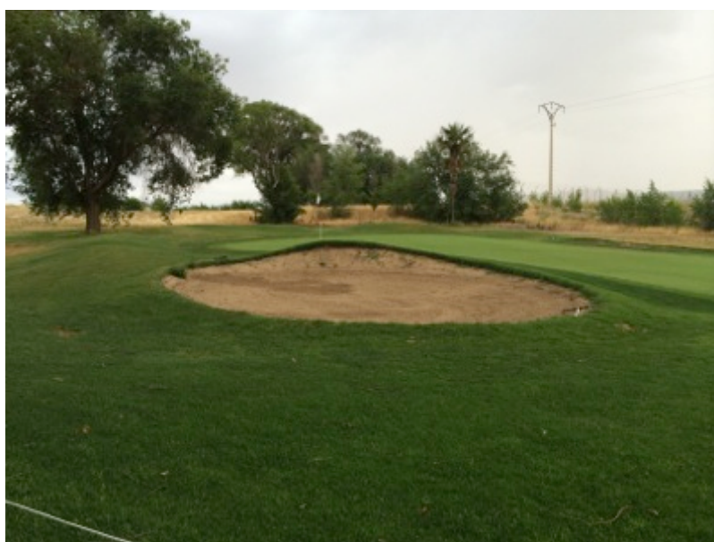
Foto 8: Detalle del estado general de los bunkers.
