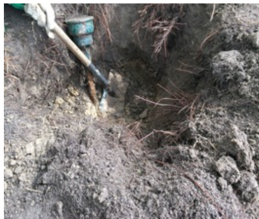
Foto 4: Detalle del zanjeado y del cambio de aspersores sobre una plataforma, para conseguir una buena triangulación y cobertura de riego entre aspersores.
