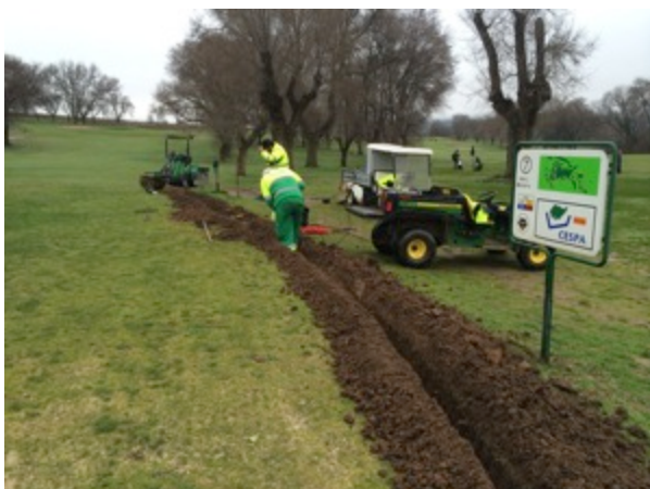
Foto 4: Detalle del zanjeado y del cambio de aspersores sobre una plataforma, para conseguir una buena triangulación y cobertura de riego entre aspersores.
