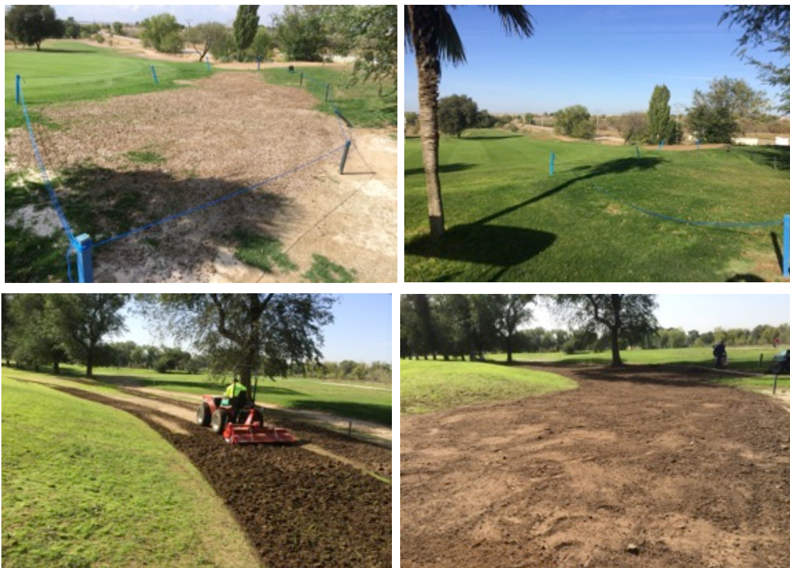
Foto 6: Detalle de la renovación de el antegreen del hoyo 13 (Arriba) y del hoyo 8 (Abajo).
