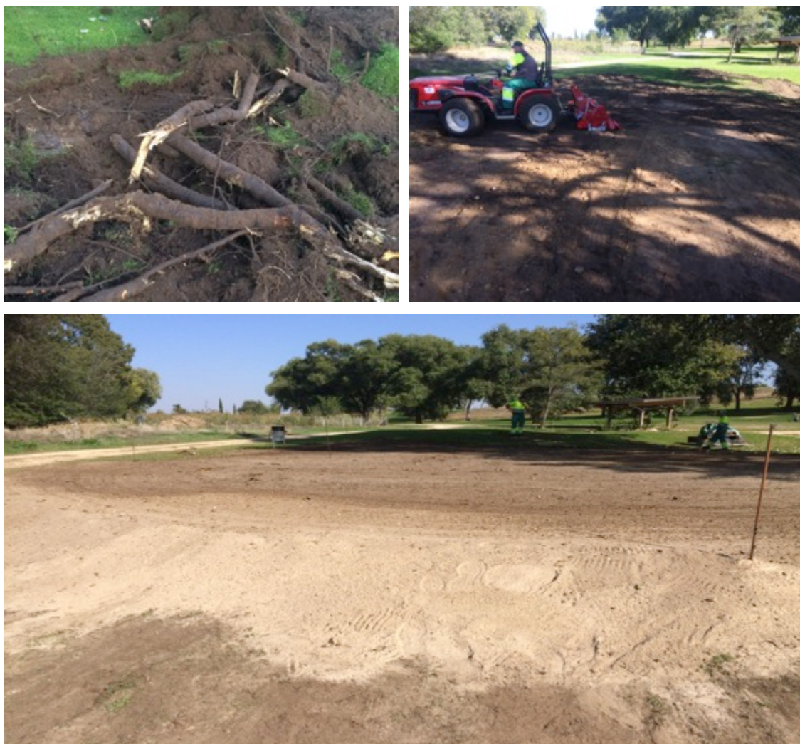
Foto 5: Detalle de la extracción de raíces del tee 9 (Arriba izq), pase de rotovator (Arriba dcha.) y nivelado de la plataforma (Abajo).
