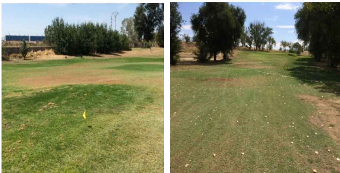
Foto 6: Detalle del estado general de las calles. En la foto, calles 5 (Izq) y 7 (Dcha).
