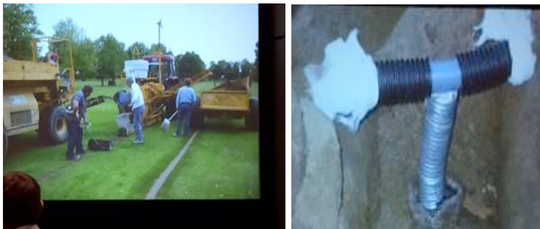
Foto 3: Detalle de el procedimiento para realizar drenajes en calles (Izq) y de los materiales utilizados para ello (Dcha).
