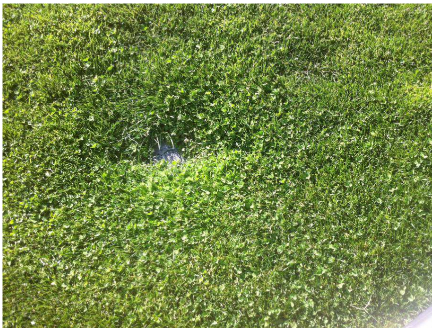
Foto 17. Aspersor sin limpiar y sin nivelar.
