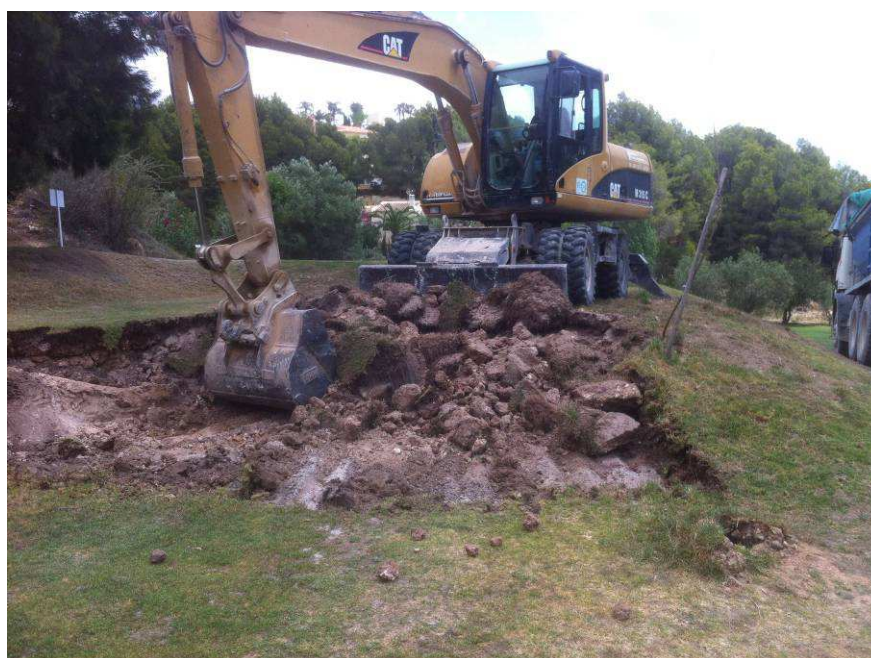
Foto 4. Modificación del Tee #7.
