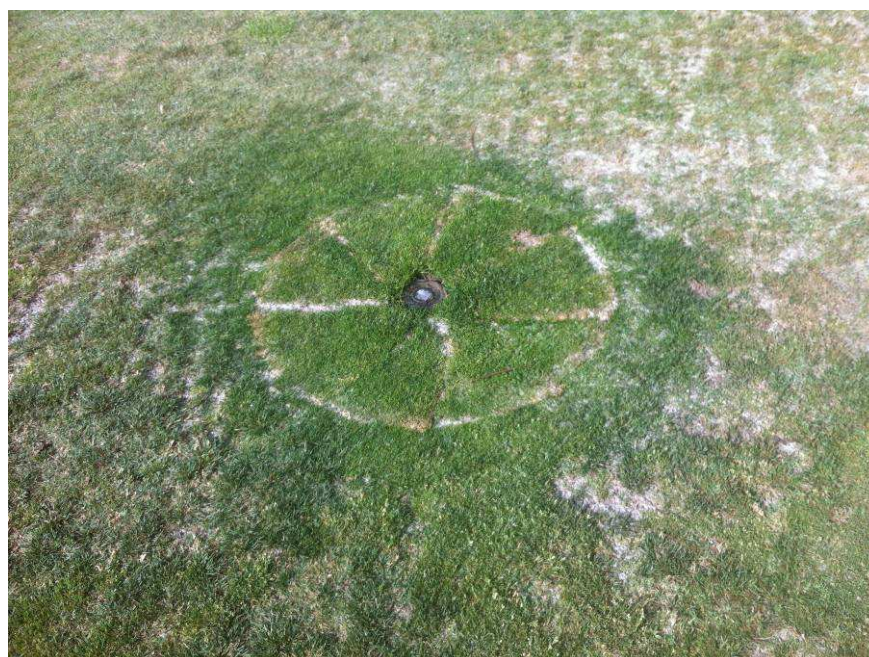
Foto 4. Aspersor recientemente nivelado.
