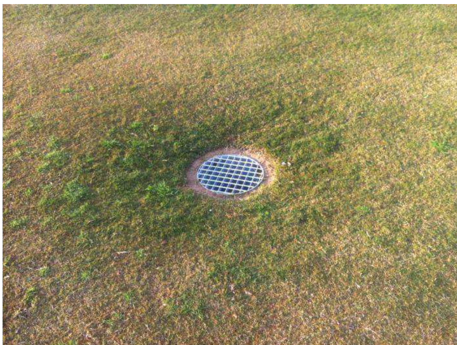
Foto 19. Arquetas bien perfiladas.
