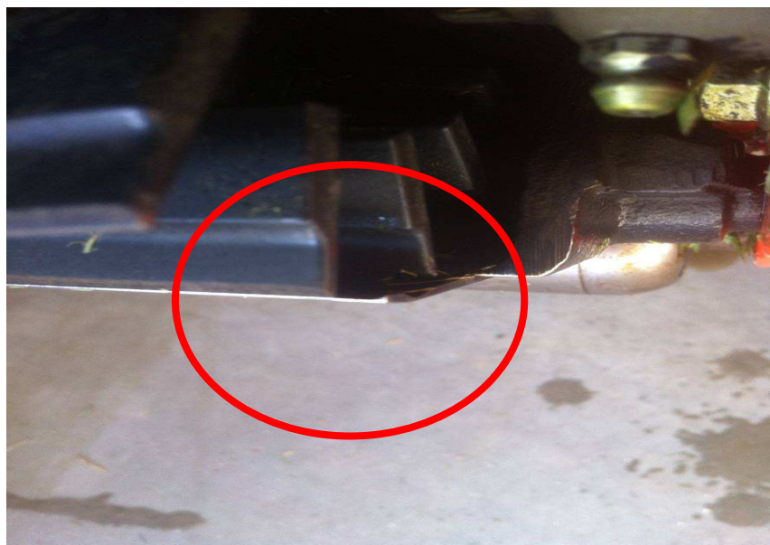
Foto 17. Estado de la contracuchilla.
