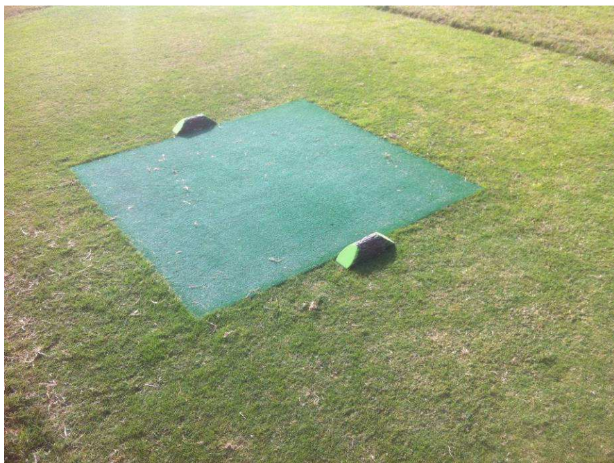
Foto 7. Alfombra integrada en la plataforma.
