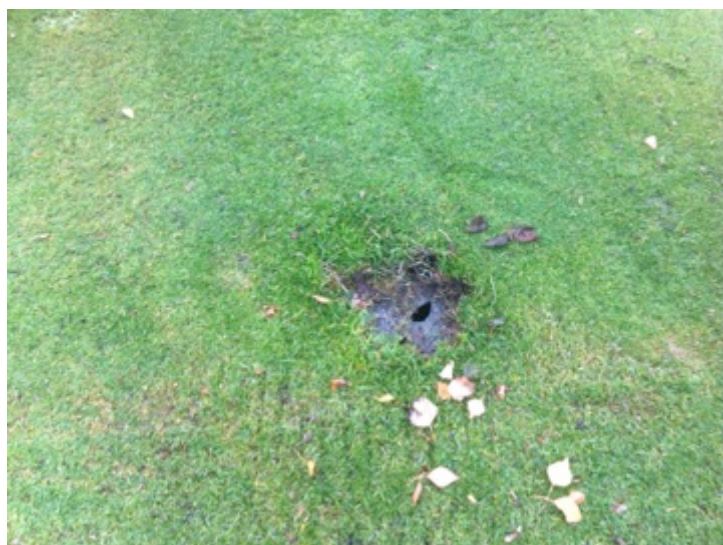
Foto 11: Detalle de arqueta de antegreen completamente enterrada.
