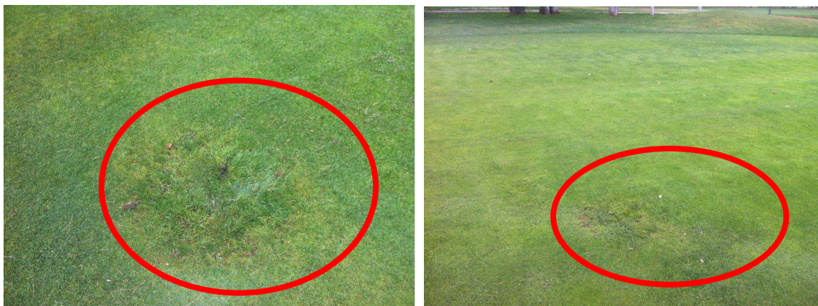
Fotos 14 y 15. Aspersores hundidos y sin limpiar.
