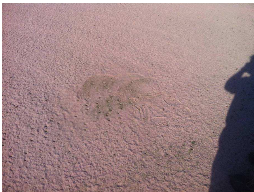
Foto 7. Cepillado de la arena para rellenar los agujeros.
