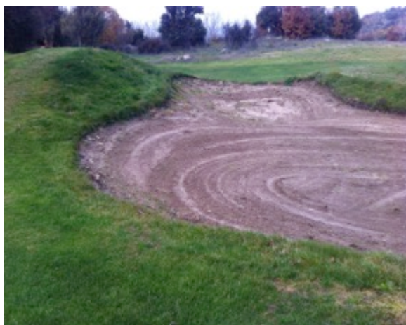
Fotos 13 y 14: Presentación de los bunkers con exceso de malas hierbas y falta de perfilado.
