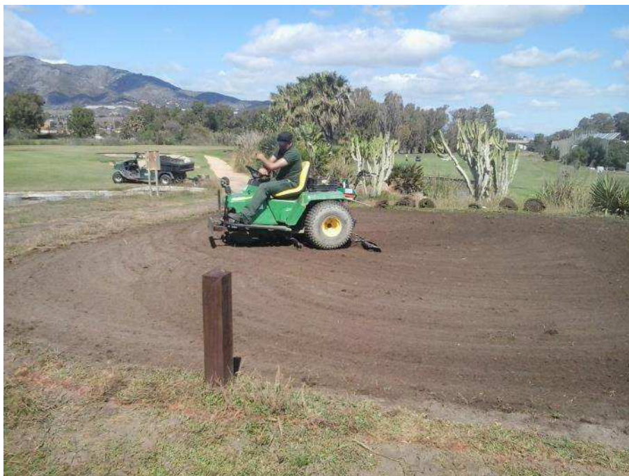
Vista eliminación de césped /materia orgánica y nivelación
