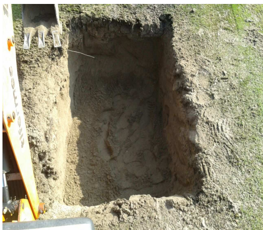
Realización de pozo para recogida de agua
