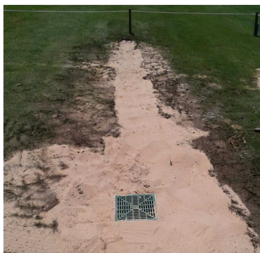
Extendido de arena silíceosa y nivelación de arqueta
