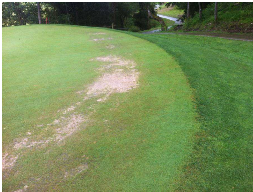
Foto 6. Zona de green dañada.
