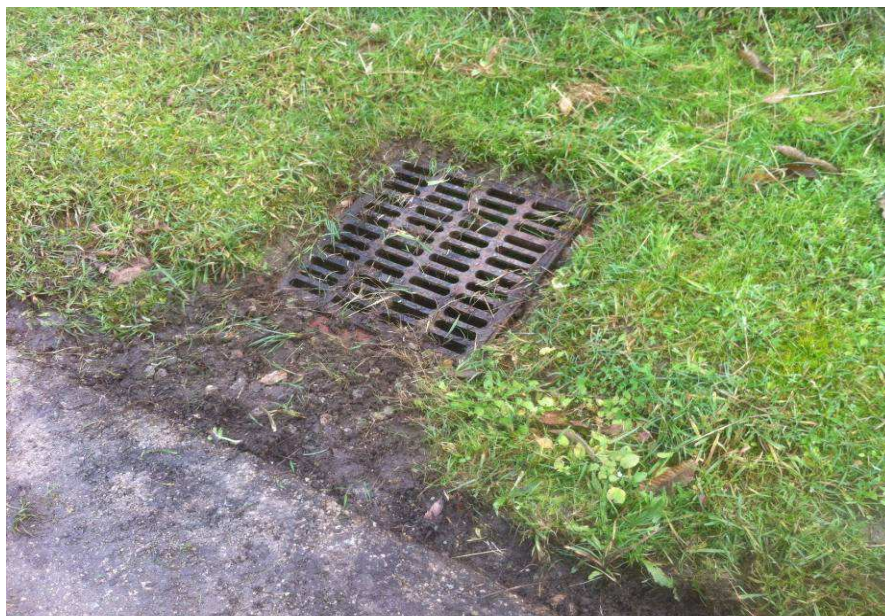
Foto 2. Limpieza de arquetas.
