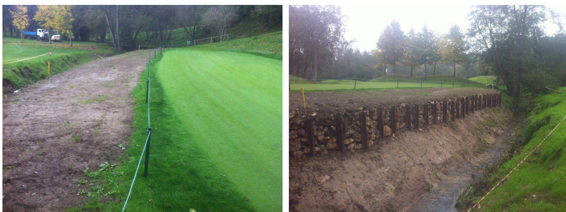
Fotos 12 y 13. Obras realizadas en el antegreen #15.
