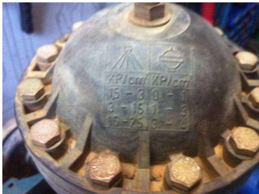
Foto 3. Válvula de compensación.
