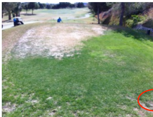
Imágenes 27 y 28: Avería de aspersor en el tee del hoyo 12 y aspecto que presenta el césped por la falta de cobertura de riego.
