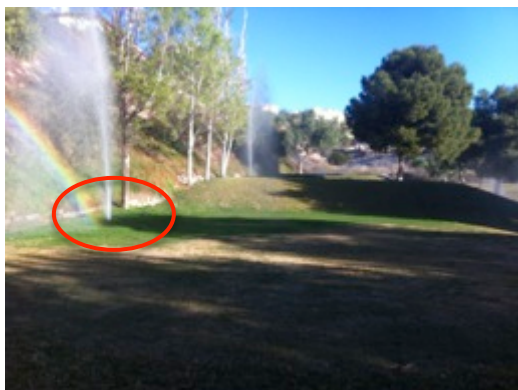
Imágenes 27 y 28: Avería de aspersor en el tee del hoyo 12 y aspecto que presenta el césped por la falta de cobertura de riego.
