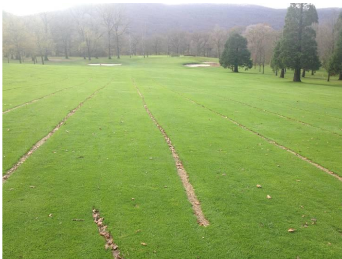
Foto 3. Drenajes realizados en la calle del hoyo 12.
