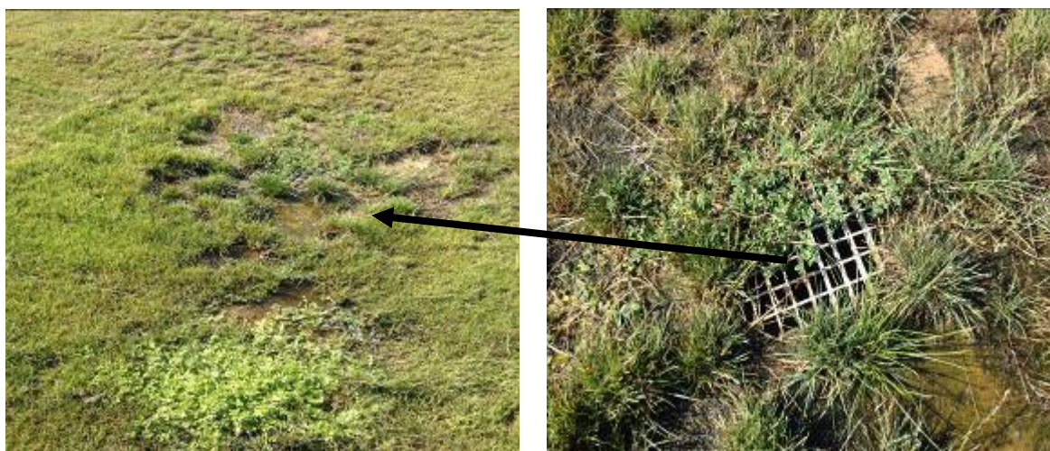
Arqueta por encima del terreno
