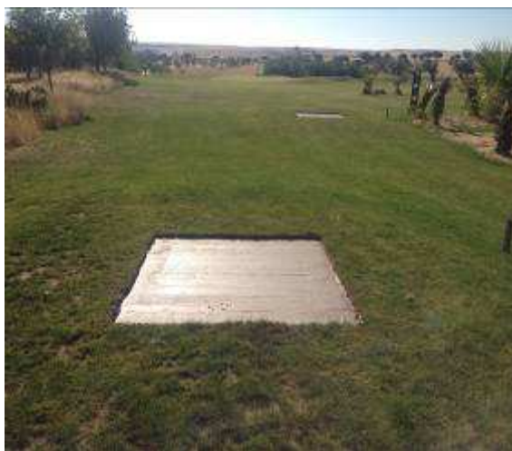
Soleras de hormigón tee del 1
