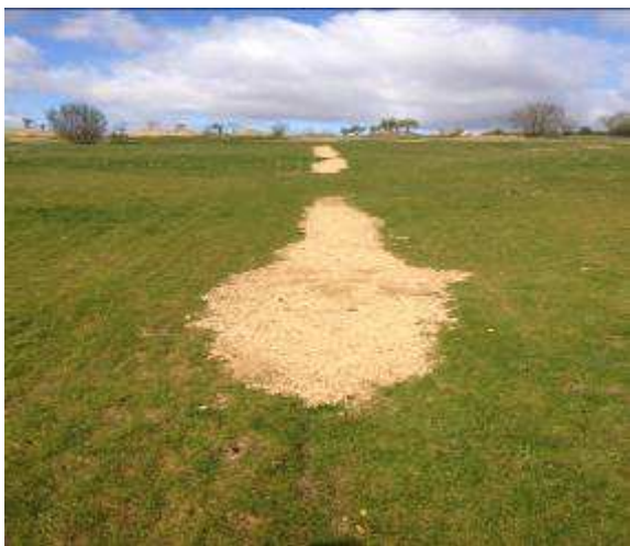
Relleno de zanja calle 4. Línea de aspersores central
