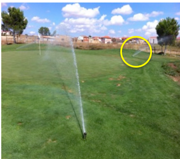
Fotos 15 y 16: Aspersor de green que no gira (izqda.) y zona de green afectada por la falta de solape y presión en los aspersores (drcha.).
