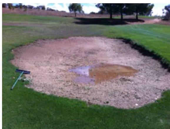
Foto 14: Aspecto general que presentan los bunkers, con costra superficial y charcos, síntomas de problemas de drenaje.
