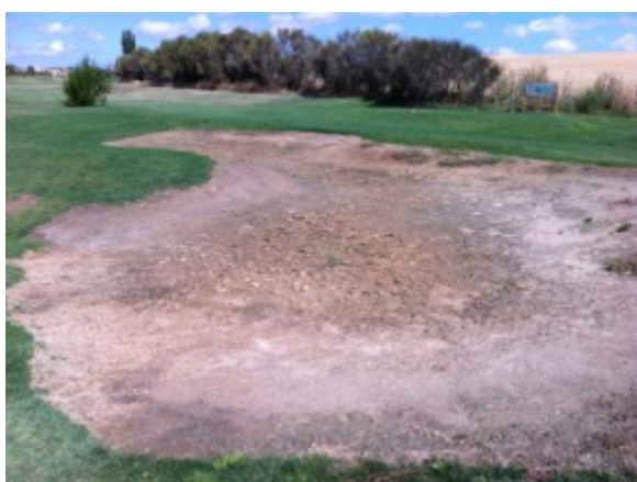
Foto 14: Aspecto general que presentan los bunkers, con costra superficial y charcos, síntomas de problemas de drenaje.
