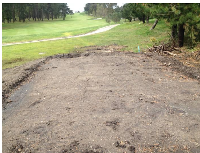
Foto 10. Inicio trabajos nueva plataforma tees hoyo 2.
